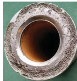
Corrosión por resquicios ( crevice )
