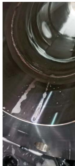
Interior de un depósito durante el desengrasado
