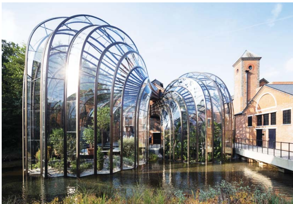
Aplicación de un sistema de protección anticorrosiva para ambientes de corrosividad C5 en la estructura de vidrio y acero de la destilería Bombay Sapphire, en Londres (2015).
