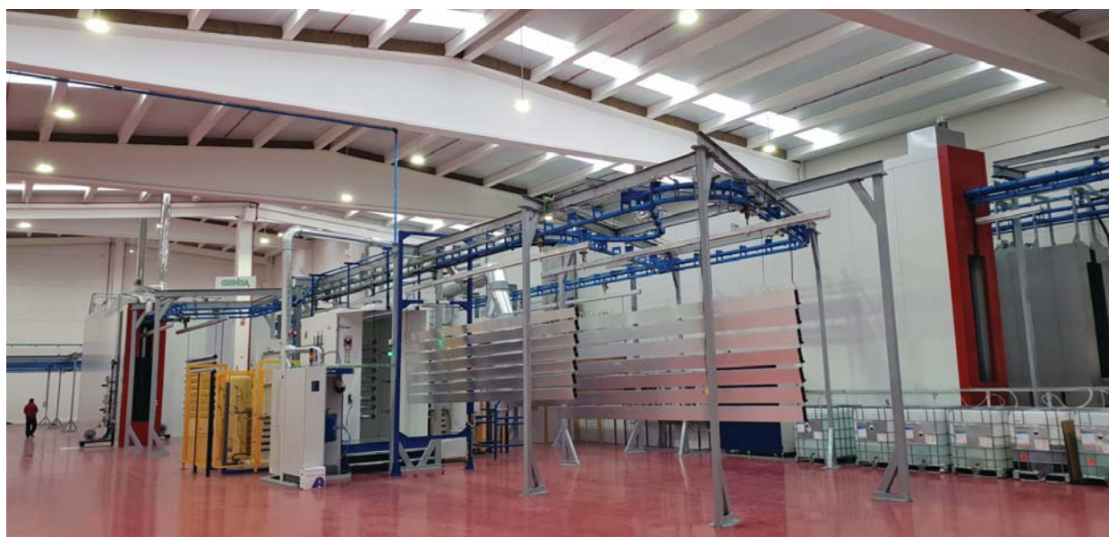
Instalación de pintura en polvo realizada por GEINSA.
