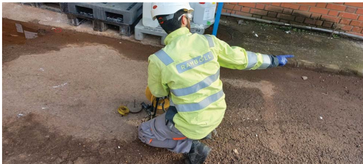
Figura 2. Ejemplo de trabajos realizados para implementar la remediación de suelos contaminados con cromo.
